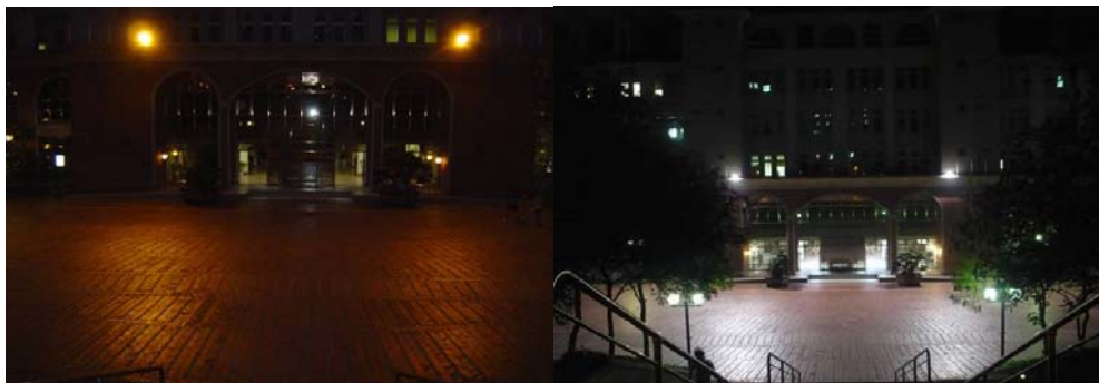
行政大樓外照明改善比較圖(左：改善前、右：改善後)
