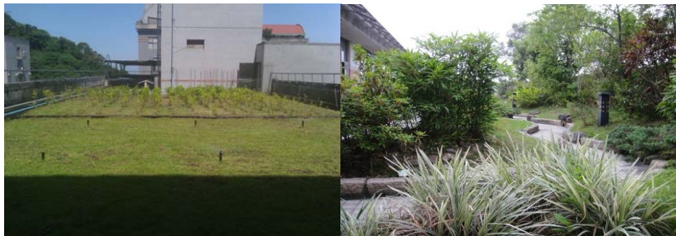
屋頂隔熱系統(左：教學大樓、右：設計大樓)
